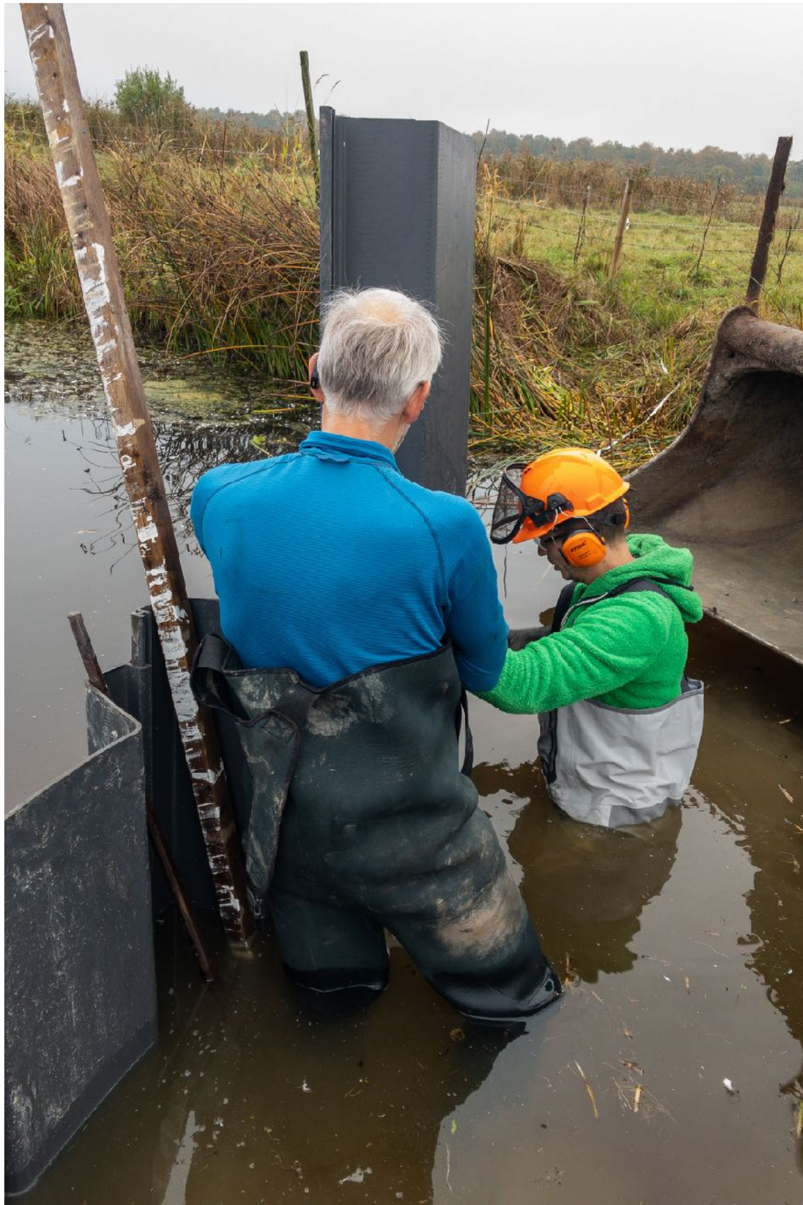
Spontning nya dämnet
